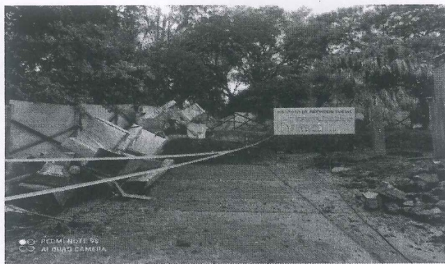
RETIRO DE MATERIALES SOBRANTES
